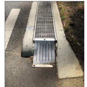
DETAIL-1 (STRIP DRAIN) N.T.S.
