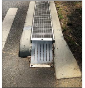
DETAIL-1 (STRIP DRAIN) N.T.S.
